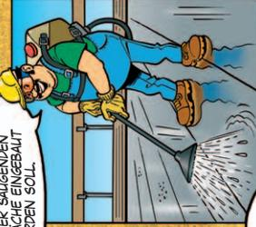
ENTFERNEN VON STAUB AUF BEREITS VORHANDENEN BETON-OBERFLÄCHEN UND FUGEN.
